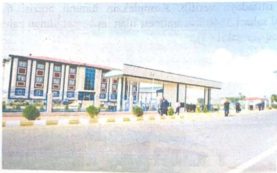
Şəkil 69. Şərur Olimpiya İdman Kompleksi
