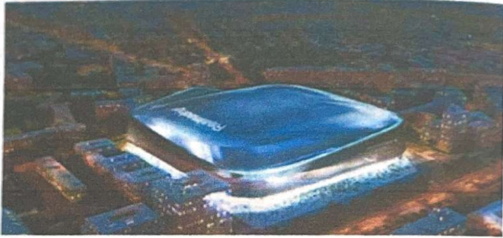
Şəkil 16. Örtülü stadion
